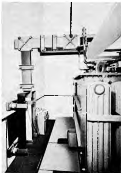
16-2. ábra Zárlati transzformátor kivezetése
